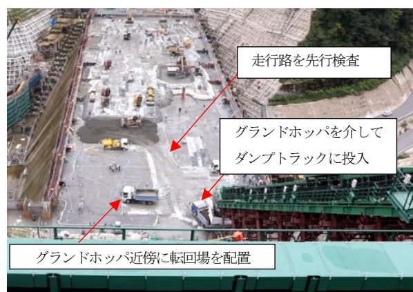
写真-2 ダンプトラックによる打設箇所への運搬状況
