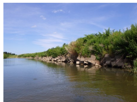
図-4 ボートから見た河岸の状況
