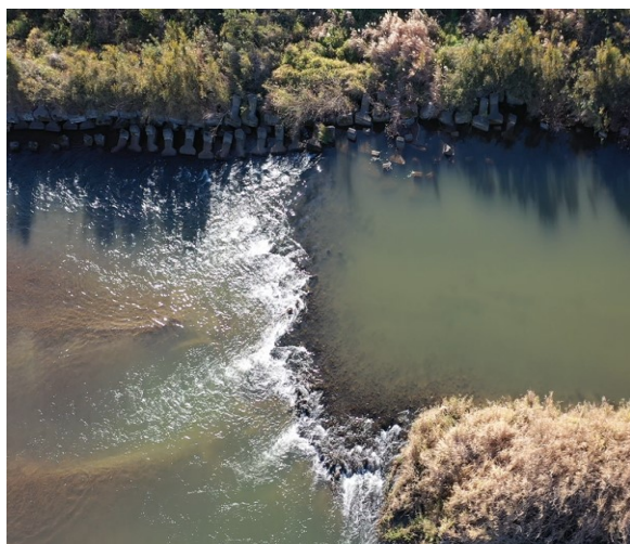
図-15 河道内の状況(堰跡)
