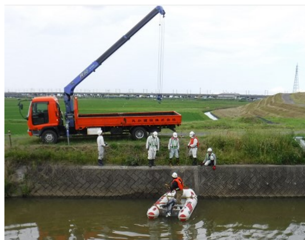
図-7 ボートの上げ下ろし作業
