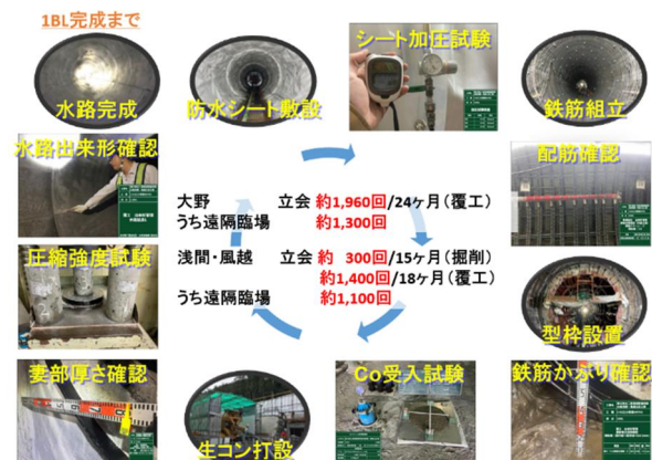
図5 覆工の施工サイクル
