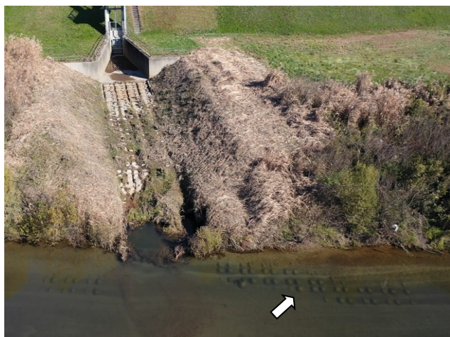
図-14 河道内(水面下)の状況
