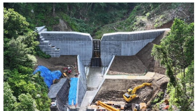
図-2 施工中の松沢川第2砂防堰堤
