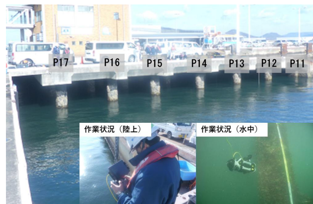
図-1 水中ロボを用いた栈橋式岸壁の点検状況
