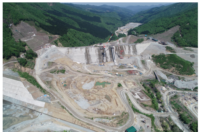
図 1 成瀬ダム進捗図（令和7年5月19日撮影）
