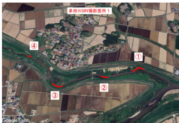
図-9 要点検箇所を記した空撮画像
