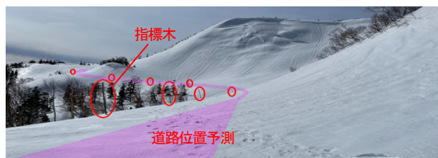
写真-2 春先除雪前の位置確認
