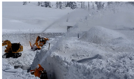
写真-9 アスピーテライン山頂付近の除雪状況（R7.4.9撮影）
