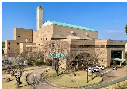
写真-1 上津クリーンセンター
