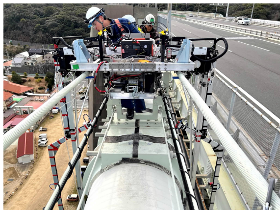
写真-3 明石海峡大橋実橋試験
