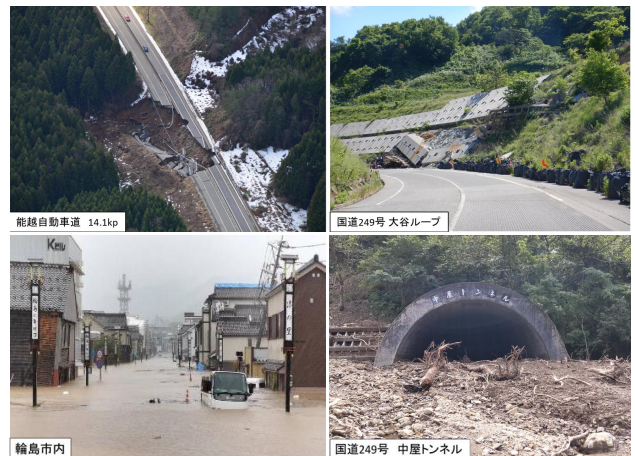
写真-1 被災状況（上：地震による被害，下：豪雨による被害）
