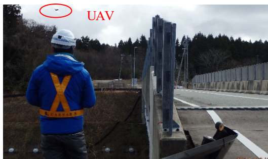
写真-1 UAVの使用状況
