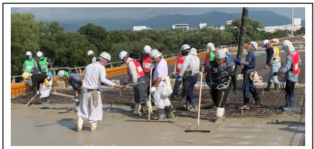
写真-4 本打設の様子
