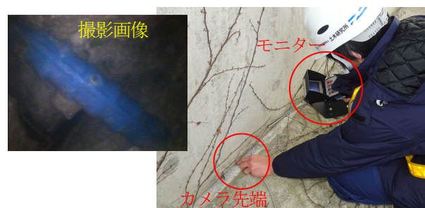
写真-4 ファイバースコープの使用状況及び撮影した内部鉄筋の様子
