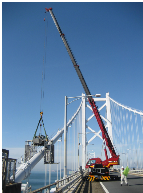
写真-1 ケーブル作業車架設状況
