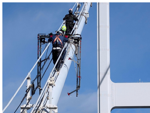
写真-2 来島海峡第三大橋実橋試験
