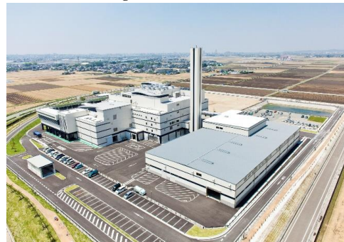
写真-1 宮ノ陣クリーンセンター
