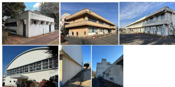
写真-1 調査を実施した建築物の外観
