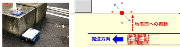
図-10 振動の計測状況
