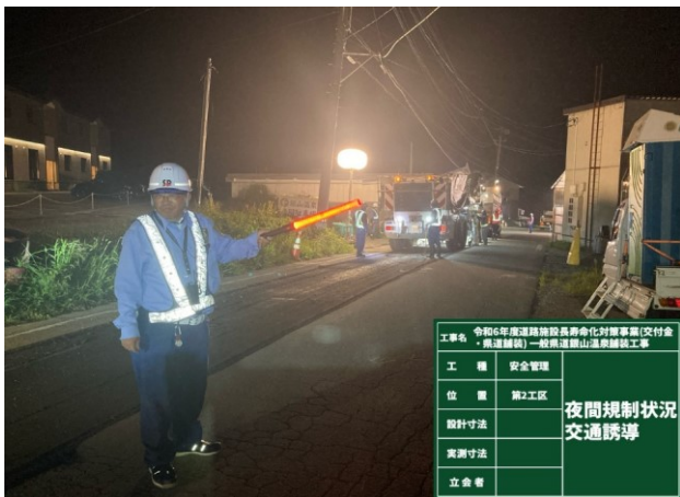
写真－4 夜間規制状況
