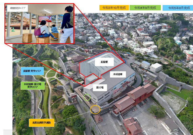
写真5：木材倉庫・原寸場・素屋根と素屋根見学エリア
