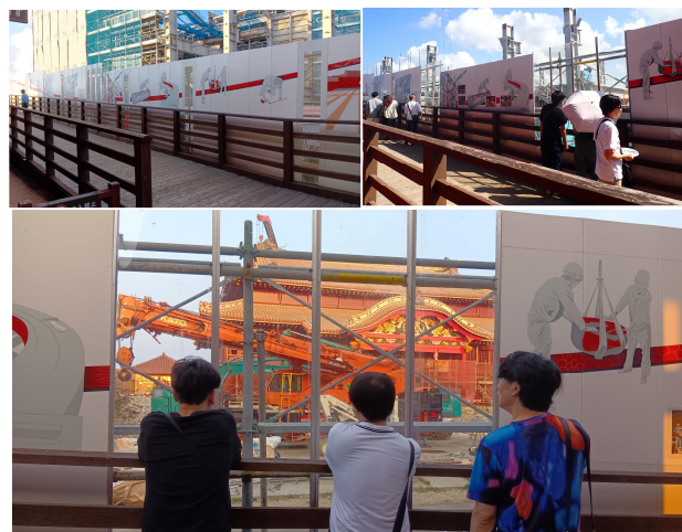
写真15：透明パネルの設置
