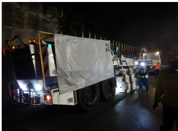
写真－7 防音シート設置状況と効果
