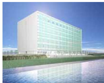
図 13 平成 16 年 2 月完成予定の松江地方合同庁舎
