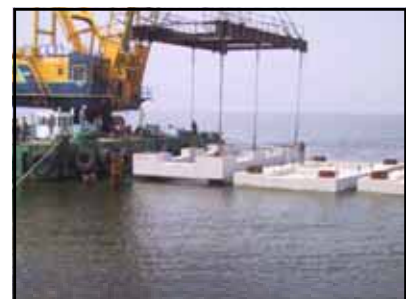
【写真-3】函体ブロック据付
