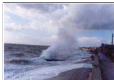
【写真-2】生地地先越波状況
