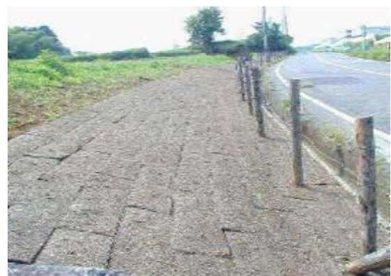
写真-3 バイオマスボードの従来工法
