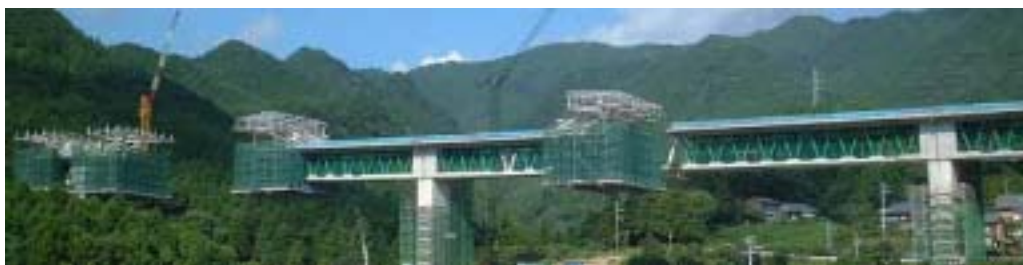
写真-3 主桁張出し架設状況
