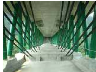
写真 - 2 主桁内部
