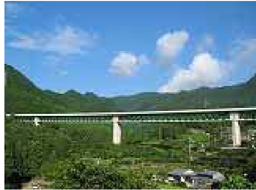
写真 - 1 木ノ川高架橋
