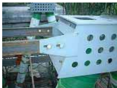
写真 - 7 斜材固定用鋼材
