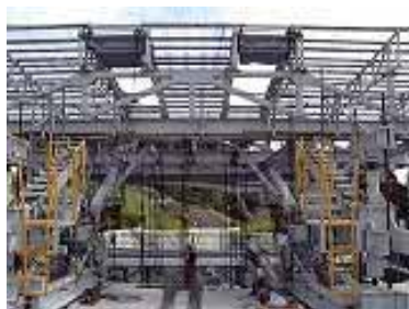
写真 - 4 開閉式屋根
