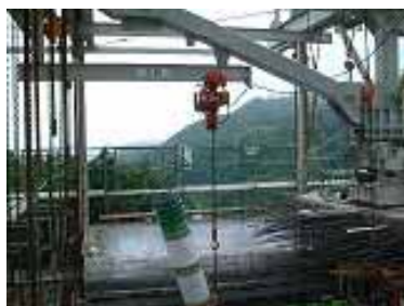
写真 - 5 斜材架設用クレーン
