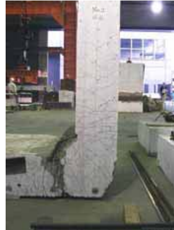
図 - 8 供試体 1 終局状況写真
