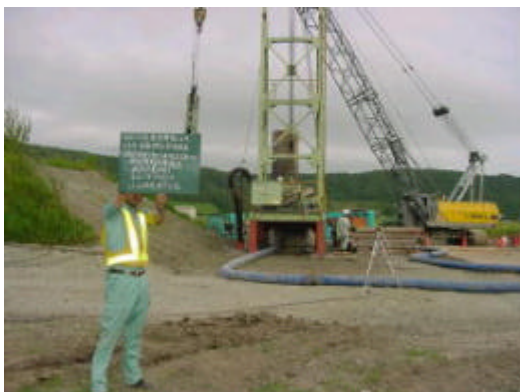
写真 3 - 2 現場測定状況
