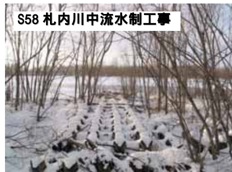
図 - 9 覆土のない水制工
