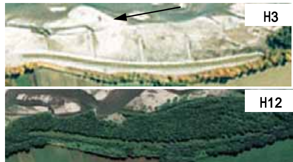
図 - 15 張芝工の経年変化 (平成元年竣工 中札内地区水制)
