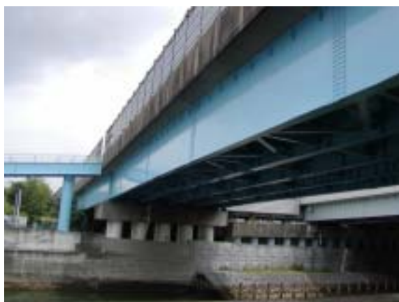
写真 - 1 パイルベント橋脚の現況(左: 弁天橋, 右: 境川橋)
