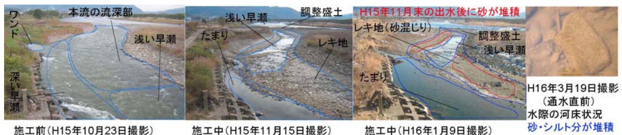
写真-1 定点写真の例（間接的に影響を受ける区間）
