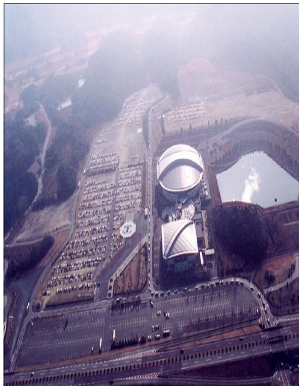
【写真-1：県営サンアリーナ臨時駐車場の状況】
