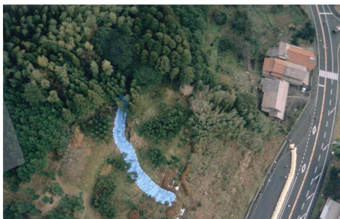
写真-1 仙山峠地すべりの全景
