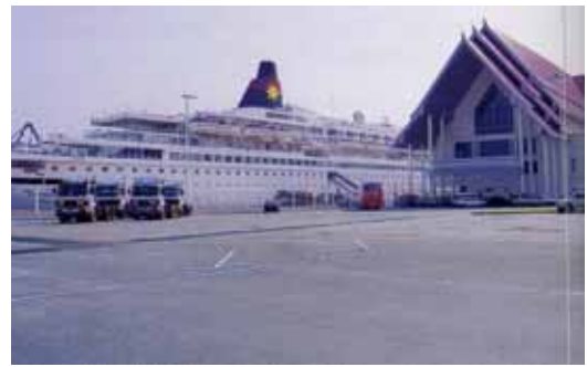
整備された旅客船ターミナルの例
