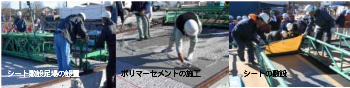
写真2 床版防水Fの施工状況
