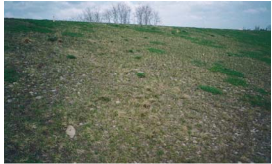
写真-1 衰退した堤防植生状況
