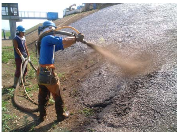
写真－3 吹付状況
