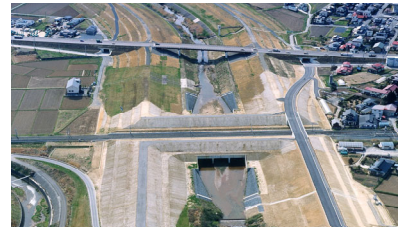
図-2. 完成状況写真
