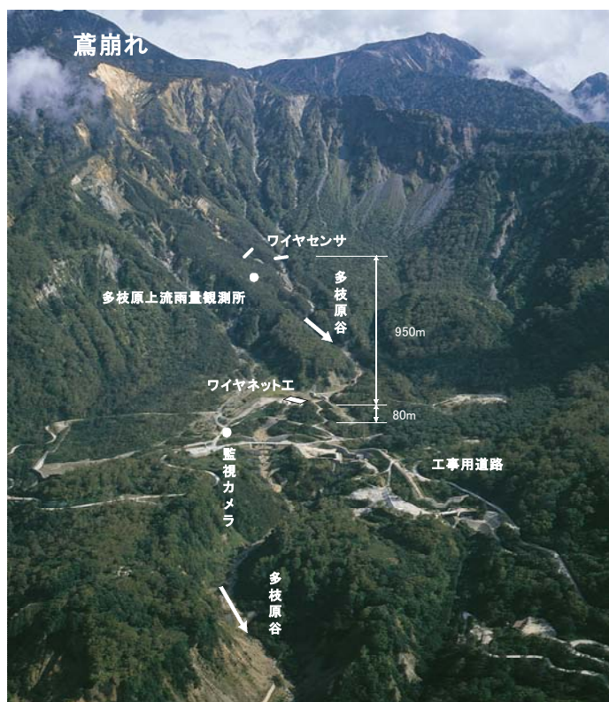
写真-1 ワイヤネット工の設置
