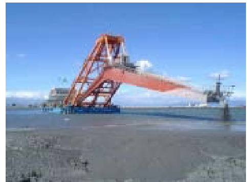
写真-2 改良浚渫土の打設状況
