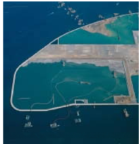
写真-1 施工中の空港島
