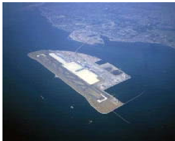
写真-3 中部国際空港（平成16年9月現在）
