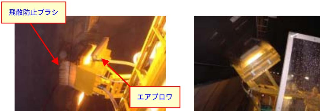
トンネル照明灯具洗浄状態
