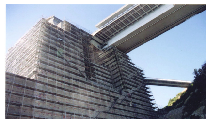
写真-1 アンカーレージの総枠組足場
