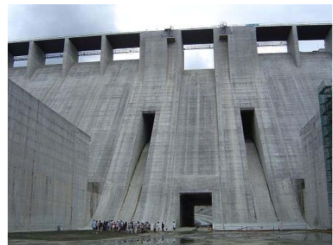
写真 - 4 仮排水路
