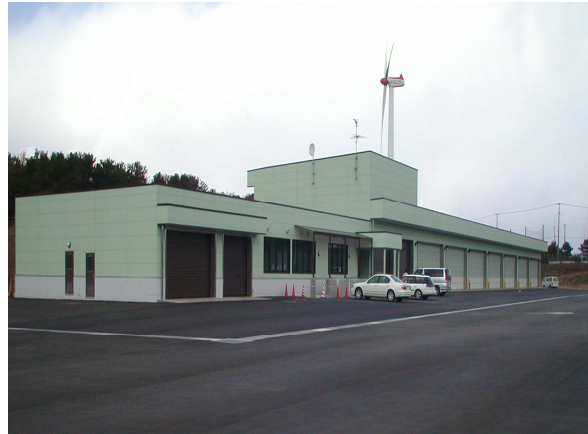
写真1 防災ステーション全景
