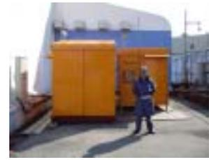
4.2 管理区域（汚染地区）は全て負圧になるよう管理し、そこからの排気ガスは2段構造の特殊フィルターを設置し、排気ガス中の化学剤の有無を最新式のガス分析計で常時モニタリングした。
