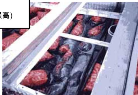
写真-7 接触酸化槽 嫌気化の状況
