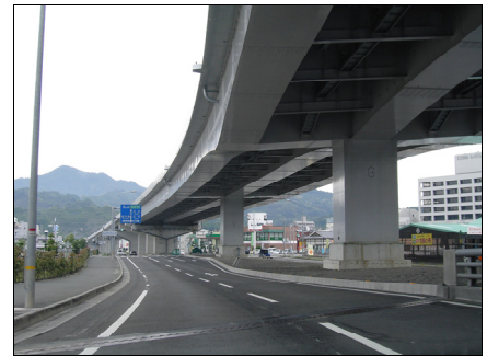
写真1 高架下の現況
