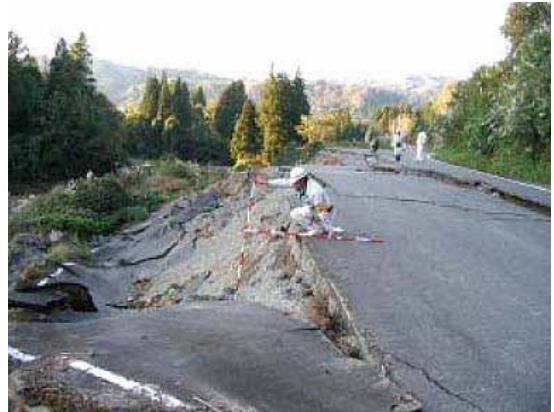
写真 - 1 点検状況
