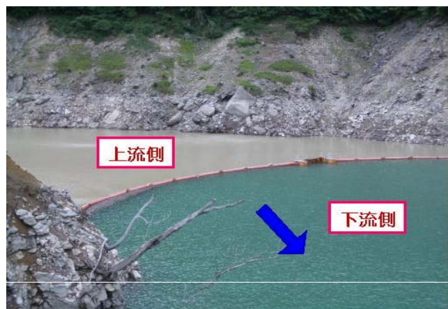
写真 1 濁水拡散防止フェンスの設置状況
