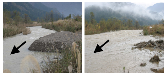
写真-1 砂の仮置き状況(放流前/ピーク流量時)
