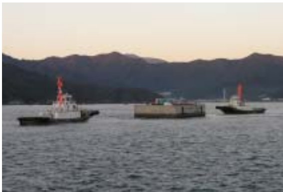
写真1 ケーソン曳航状況
