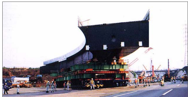
写真1 台車一括架設工法（参考）
