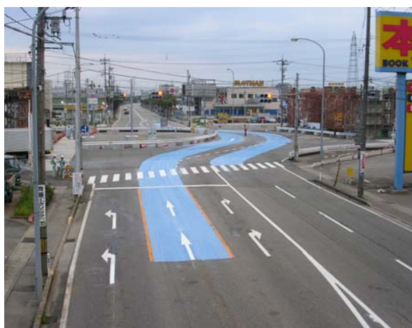
写真2 架設前交差点状況
