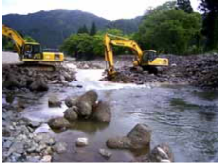
写真 - 3 河道掘削
