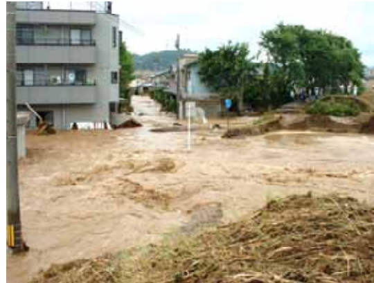
写真 - 1 破堤状況
