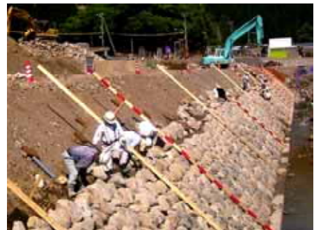
写真 - 6 石張状況
