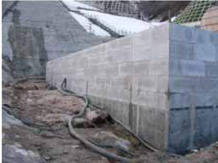
写真2 型枠C施工状況(フーチング部:表面)
