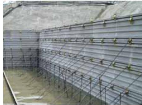
写真3 型枠C施工状況(フーチング部:背面打設部)
