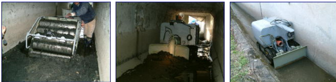
写真－3 現場適応性試験状況（左から：トレンチャ式、直接吸引式、排土板式）
