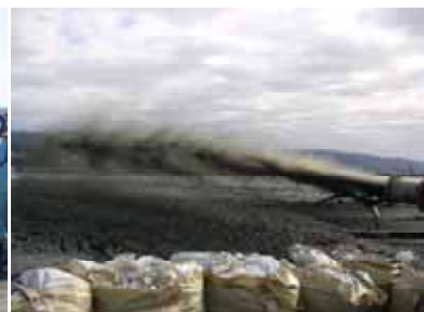
写真-2 直吹き打設
