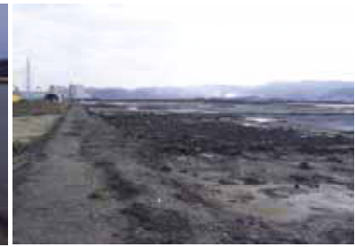
写真-4 固化版造成後
