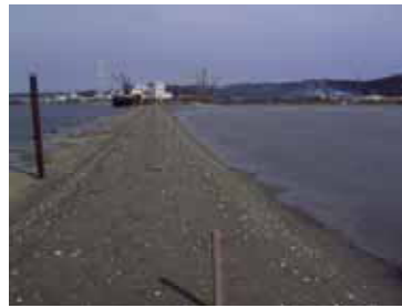
写真-3 固化版造成前
