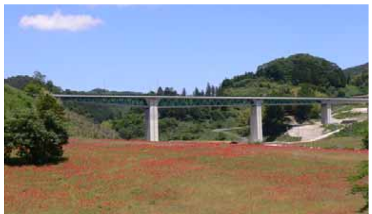
写真-5 完成写真
