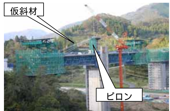
写真-1 ピロン支柱及び仮斜材
