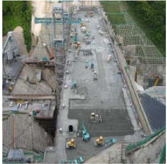
写真 - 1 連続 RCD 施工状況
