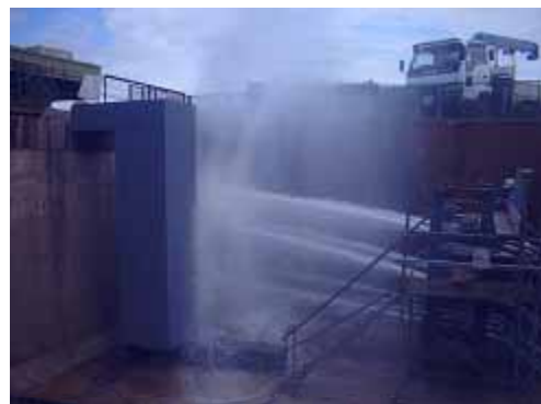
写真 - 6 放水実験状況
