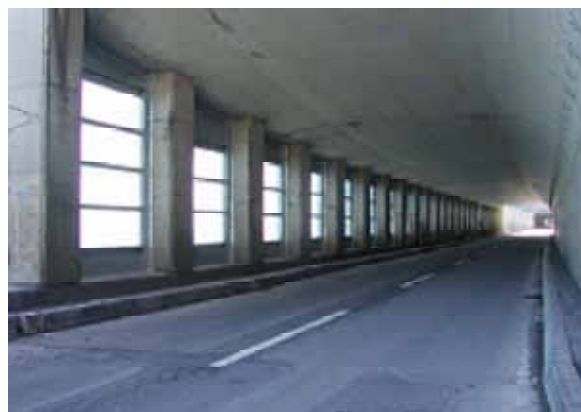
写真 - 8 完成した汐鳴覆道越波防止柵 (覆道側)
