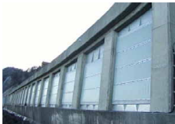
写真 - 9 完成した汐鳴覆道越波防止柵 (海側)
