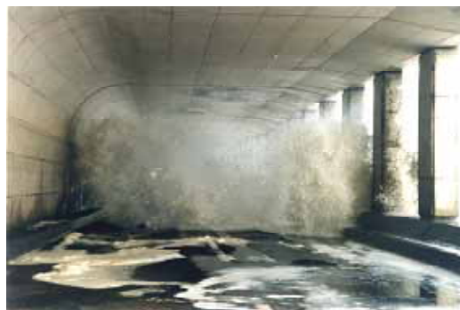
写真 - 1 越波の状況
