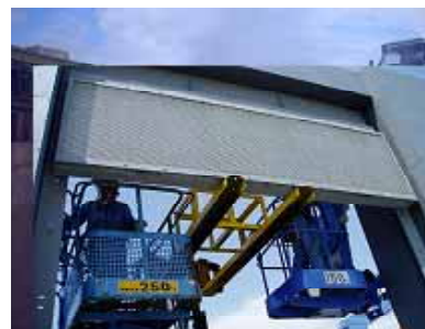
写真 - 7 施工実験状況
