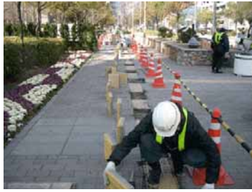
写真-3 施工状況
