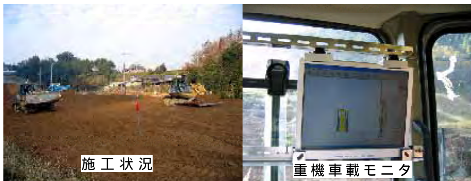
図-14 施工状況と重機車載モニタ
