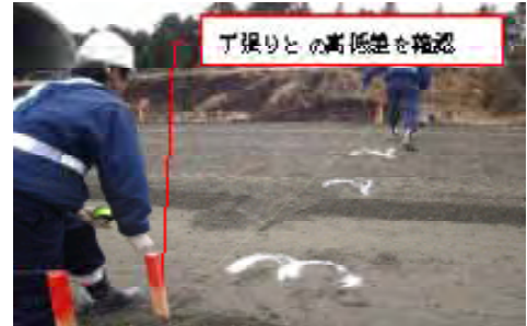
写真-1 現行の出来形確認作業
