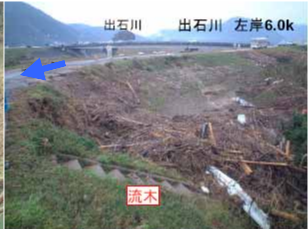
図4.4.2 流木化した河道内樹木 (越水により堤内地に流出) (円山川水系出石川)
