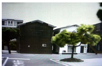
図5. CCDカメラを用いた現状の建物確認
