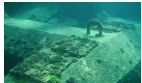
写真 - 3 : 凹凸加工ブロックに着生したサンゴ(那覇港)
