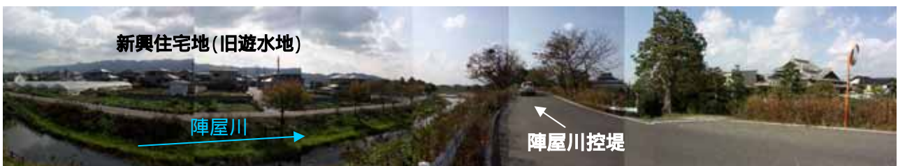
図 10：新しい住宅の建ち並ぶ左岸堤防よりも 3m 程高い右岸の陣屋川控堤周辺
