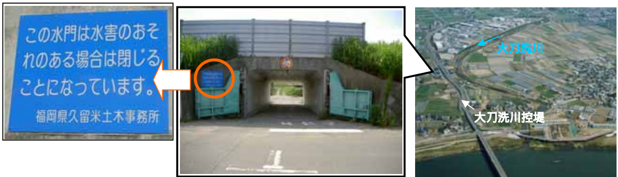
図 9：控堤をボックスが横断しているが、氾濫水の浸入を防ぐための門扉がついている大刀洗川控堤
