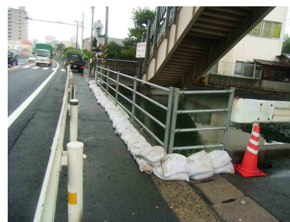
写真-4 土嚢設置状況
