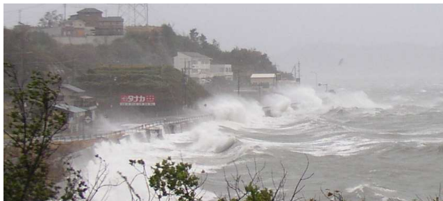
写真-1 国道185号の越波状況
