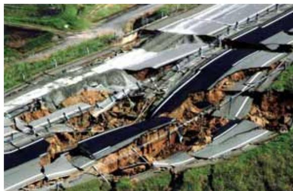
写真 - 1 盛土部の大規模崩壊状況
