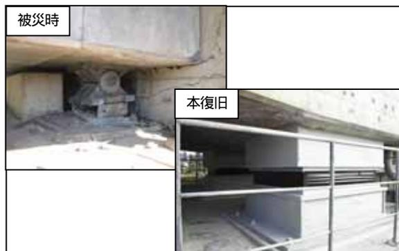
写真 - 8 鋼製支承からゴム支承への変更
