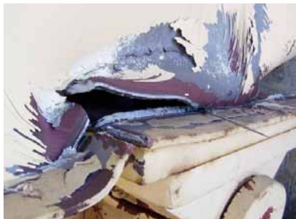
写真 - 2 橋梁支承損傷状況
