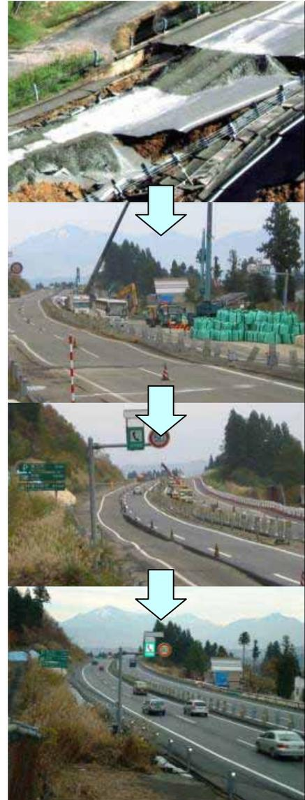
写真 - 4 応急復旧の段階施工
