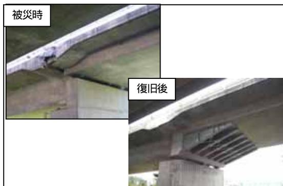
写真 - 7 上部工桁の連結 (芋川橋)
