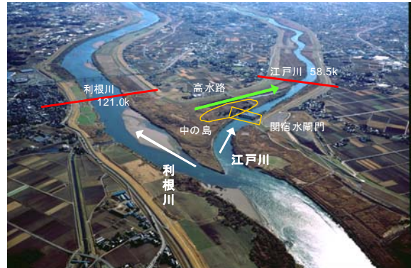
写真-1 分派点現状(平成17年12月撮影)
