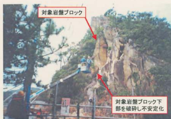
写真-2 不安定化実験斜面の状況
