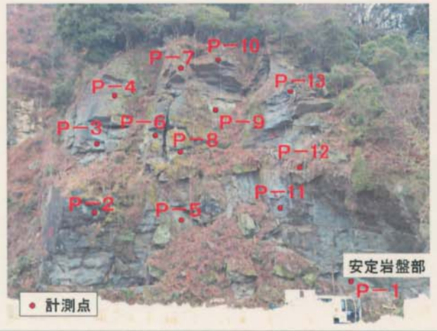
写真-3 B地区の岩盤斜面状況及び計測点の配置
